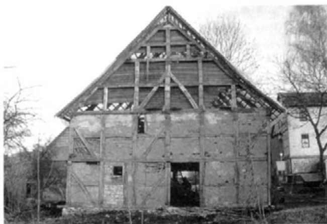
Die Westseite der Roringe Pfarrscheune
