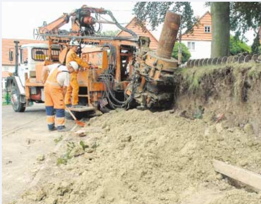
Bohrungen: Nico Warminsky und Wilfried Matthies (vorn) bereiten die Sanierung vor. Hinzmann
